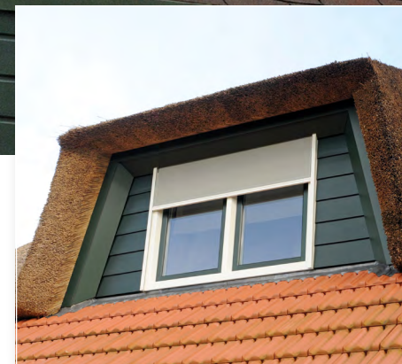
Gevelbekleding, boeiborden en dakrandpanelen
