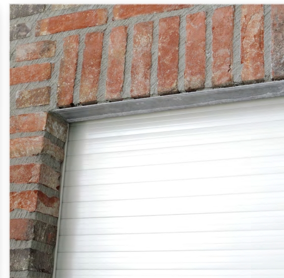
Rolvent screen/rolluik, inbouwscreen of inbouwrolluik. Weggewerkt achter de gevel. Voorzien van ventilatierooster met een vaste maat.
