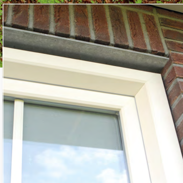
Duco Top, ventilatierooster weggewerkt in de gevel, van buitenaf niet te zien. Dagkant afwerking ook van kunststof in gewenste kleur
